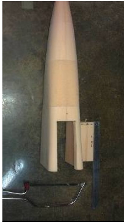
15 -Réaliser la découpe de 4*10 cm dans le Roofmat pour le passage du train avant.
