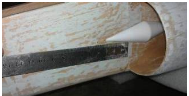
8-Placer celles-ci centrées en hauteur et les faire sortir de 3cm.
